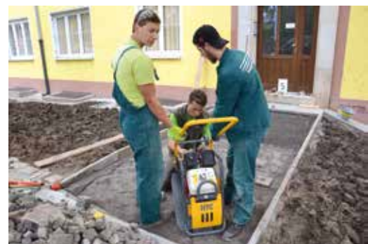
Pokládání obruby z žulových kostek
